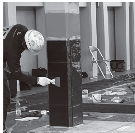
シート貼り付けの仕上げ
